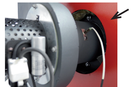
Abb. 13: Sensor der Rauchgasauslässe
