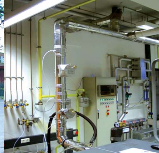
Prüflabor für Zugbegrenzer und Abgasklappen.
