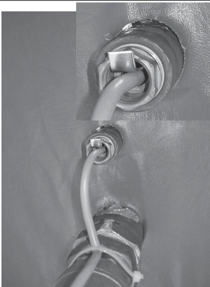
Temperatursensor des unteren Teils des Behälters KSPF eingesteckt in Schutzhülse.
