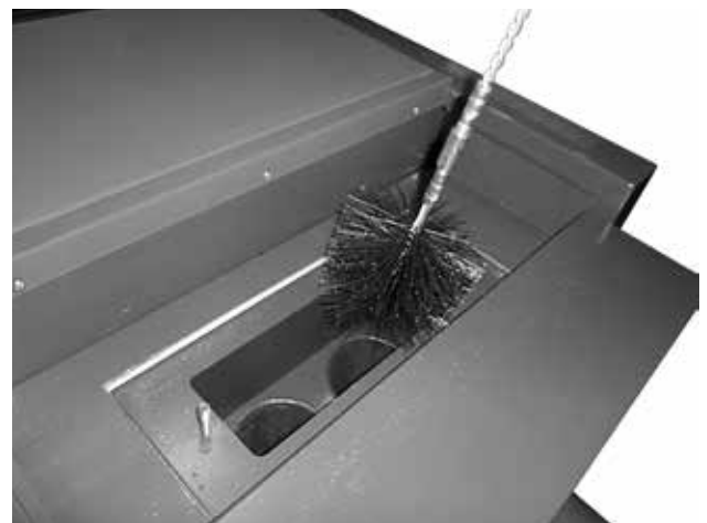
Gründliche Reinigung des Rohraustauschers (Rohrwand) mit der Bürste
