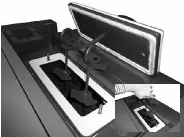
Beispiel des Herausnehmens der Bremsenlemente aus dem Rohraustauscher (Rohrwand) vor der gründlichen Reinigung
