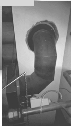
Schlechter Anschluss an das Zugloch – undicht und keine Reinigung möglich
