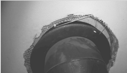
Schlechter Anschluss an das Zugloch – undicht und keine Reinigung möglich
