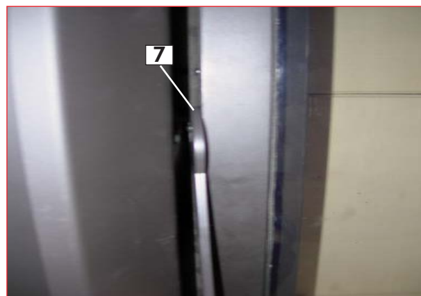
Figure 3 : blocage porte ouverte (tourner le loquet à 90°)
