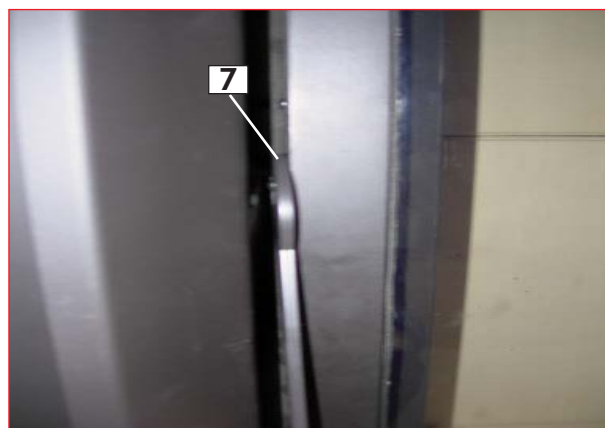
Figura 3: bloqueo puerta abierta (girar el trinquete 90°)
