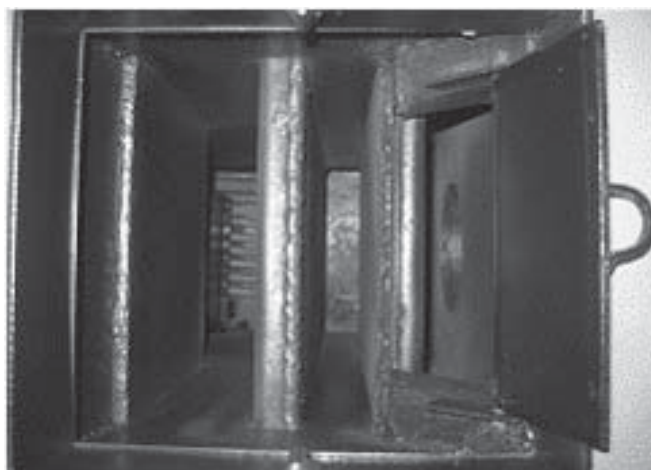
Abb. 16 Sehr sauberer Tauscher des Kessels.
