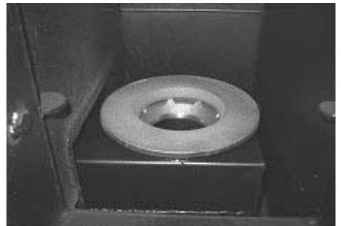
Abb. 14 Sehr saubere Brennkammer des Kessels.
