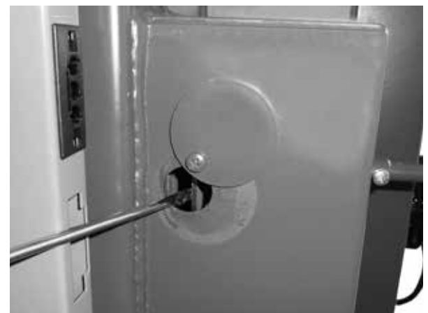
Die Kontrolle und die Reinigung der Kontrollöffnung – Zugstange für Primär-sekundärlufteinstellung
