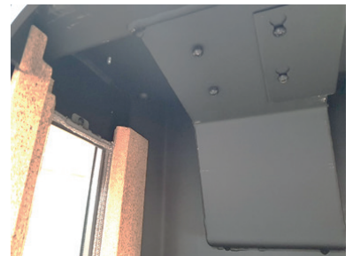
6: Lösen Sie die 4 Inbusschrauben mit einem 4mm Inbusschlüssel (Siehe Foto Nr. 6a). Die Stahlumlenkungen 1 und 2 werden leicht zurückgeschoben und können dann entfernt werden. Der Kaminofen ist jetzt zur Reinigung bereit.
