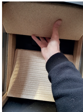
5: Die obere Rauchumlenkung kann jetzt entfernt werden.
