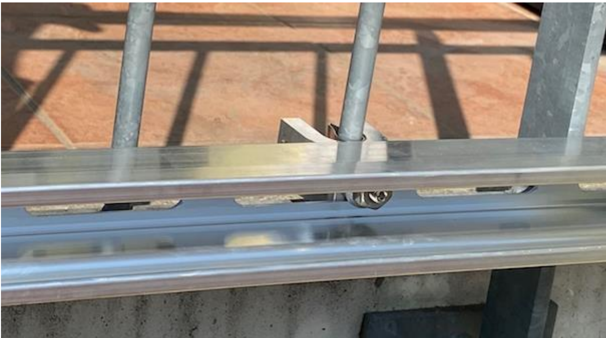
Abbildung 11/Montageschiene und Spezialklemme von außen
