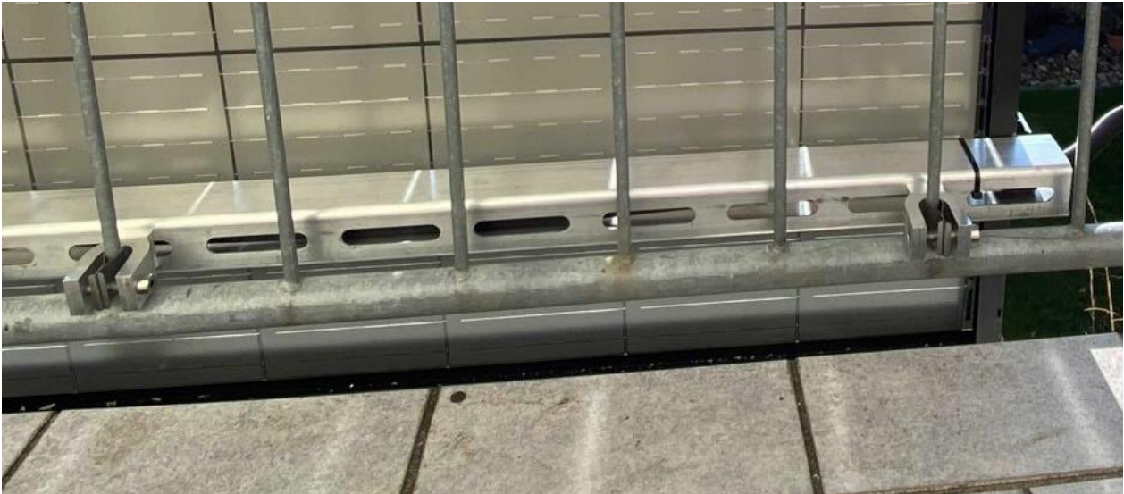
Abbildung 10/ Montageschiene an Spezialklemme
