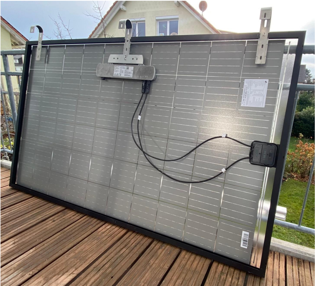
Abbildung 7/vorbereitetes Solarmodul mit 3 Befestigungsbügel und Wechselrichter
