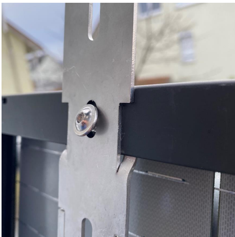
Abbildung 5/locker angesetzte Schraube M6 kurz
