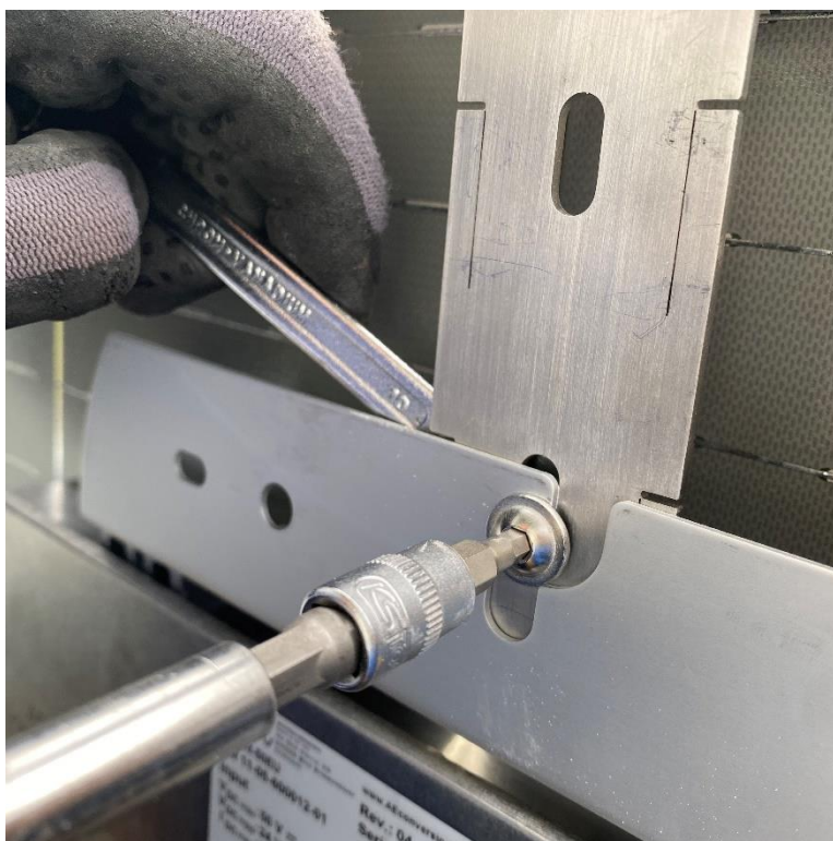
Abbildung 6/Wechselrichter am SOLAR-HOOK Befestigungsbügel anschrauben
