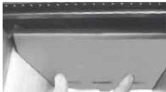
Εικ. 14: ανύψωση του διαχωριστικού φλόγας
