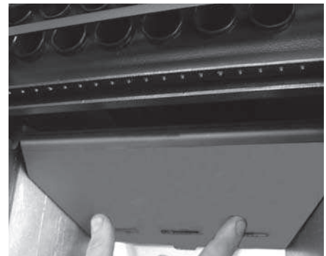
Abb. 14: Ziehen Sie die Feuerschutzwand hoch
