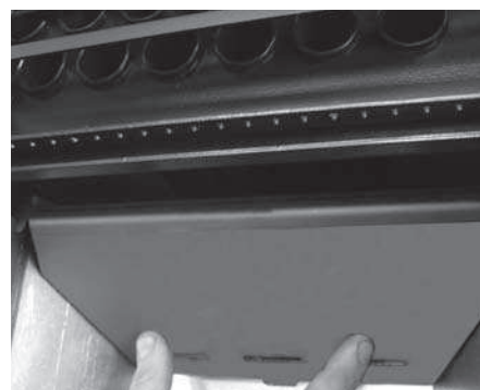
Fig. 14: soulever la plaque coupe-flamme
