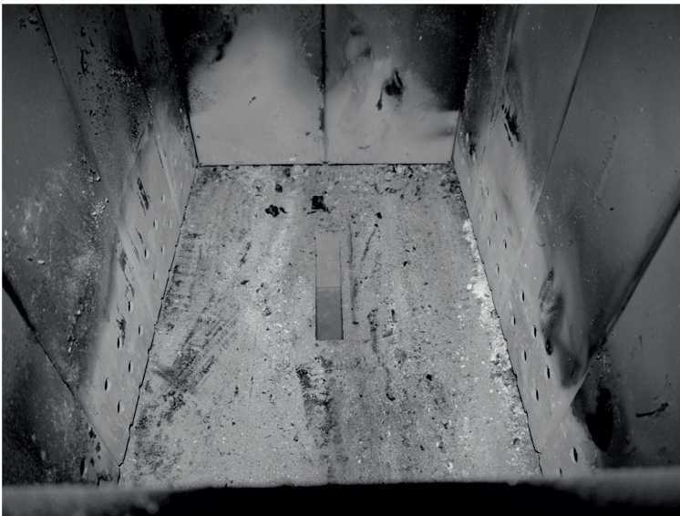
Bild 6. Richtig gereinigte Ladungskammer
