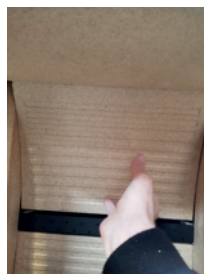
3: Når den øverste røykhylde plate fra instruksjon 2 er løftet, kan den øvre vermikulitt-bakplaten løftes over tertiærbjelken.
