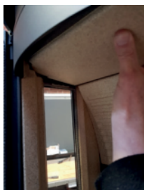
2: Avancez-le délicatement au-dessus des deux vermiculites « tours » des angles.
