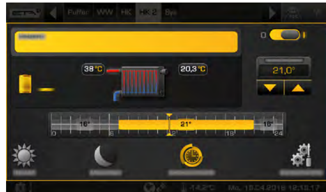
Abb. 7-64: Übersicht mit Heizkörper
