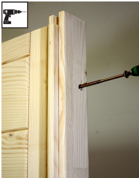
8 vis 6 x 120 mm par montant d'angle
