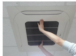
Überprüfen Sie die linken, rechten und zentralen Abschnitte
