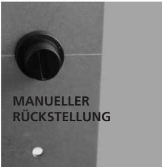
**Sicherheitsthermostat mit manueller Rückstellung für die Wassertemperatur:** wenn die Wassertemperatur den eingestellten Sicherheitswert von 100° C überschreitet, wird der Betrieb des Heizofens sofort gestoppt und auf dem Bildschirm erscheint **"ALAR-SIC-AUSFALL"**. Für den Neustart muss der Thermostat manuell zurückgestellt werden.
