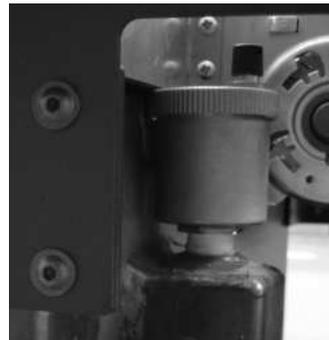
**Automatisches Entlüftungsventil:** dieses Ventil entfernt die Luft im Inneren des Heizofens und der Heizanlage.
