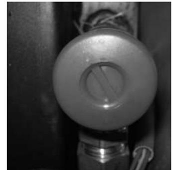
**Sicherheitsventil:** dieses Ventil greift ein, um einem Überdruck der Hydraulikanlage vorzubeugen. Wenn der Druck des Heizofens oder der Anlage 2,5 bar überschreitet, lässt das Ventil Wasser aus dem Kreislauf ab.
