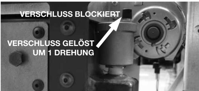
Der Fülldruck der Anlage **IM KALTENZUSTAND** muss **1 bar** betragen.
