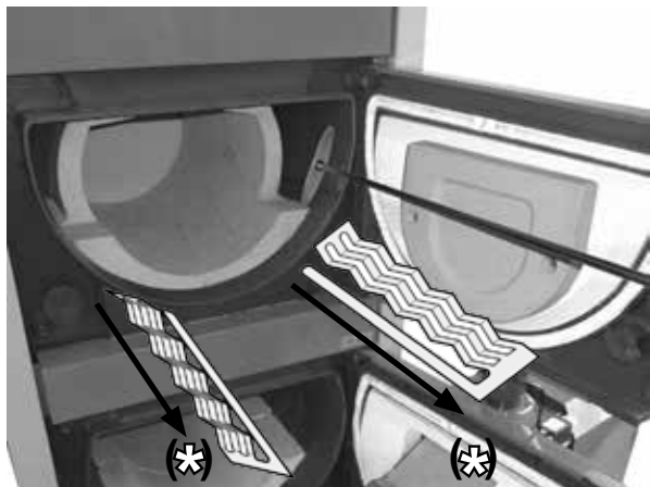
Offene mittlere Kesseltür mit dem Muster, wie die Asche durch das Schüreisen gereinigt ist. *Nur bei DC30GSP.
